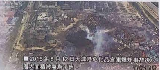
2015 年 8 月 12 日天津港危化品倉庫爆炸事故後，廣大面積被夷為平地。
