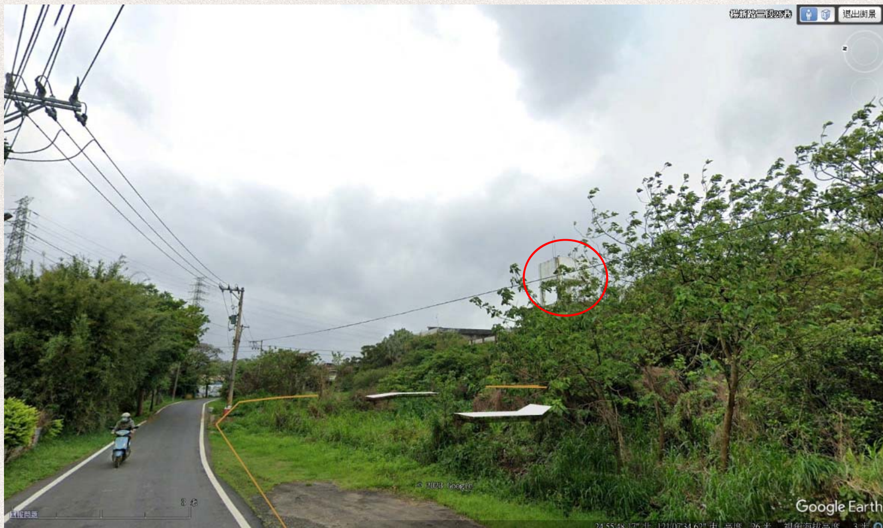
施添福圖14瑞原里路邊水塔（Google Earth 2023/12/27）
